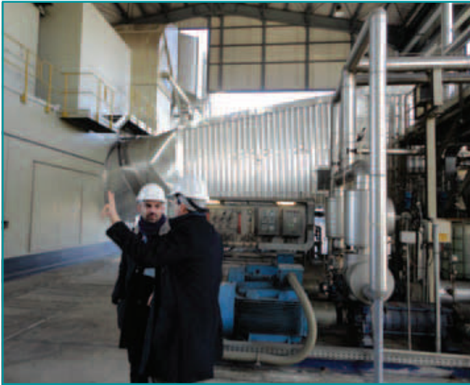
Abbildung 2: technische Koordination am Flughafen Malpensa. Quelle Fraunhofer ISE
